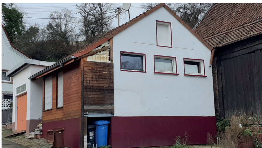
Leerstehendes Wohngebäude im Bereich der Hauptstraße
