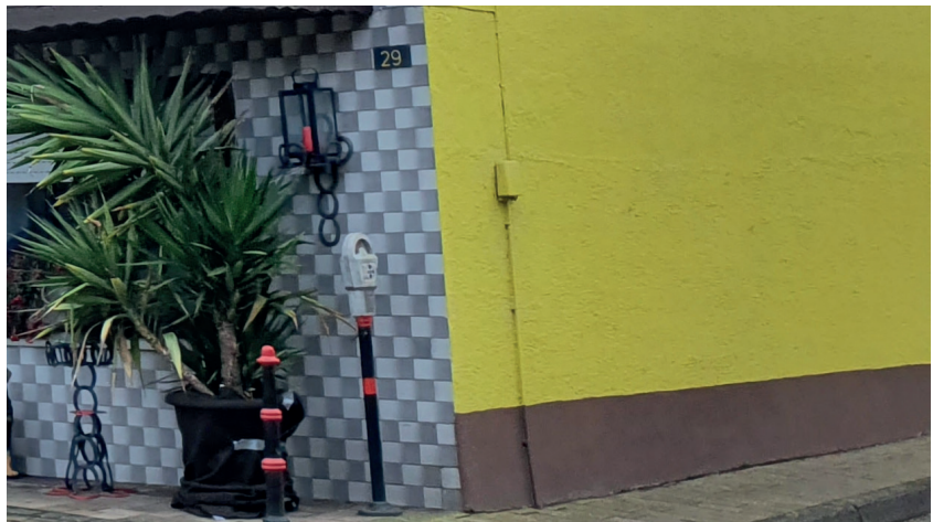
Ortsuntypische Materialität/Farbgestaltung der Fassade
