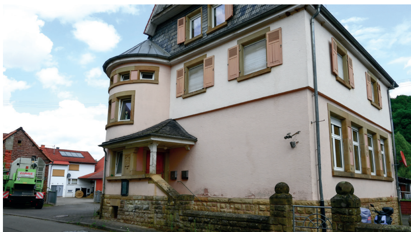
Denkmalgeschütztes Schulhaus, Untersulzbach
