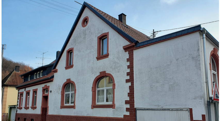
Ortsuntypische Materialität der Fenster (Kunststoff mit zu breiten Streben)
