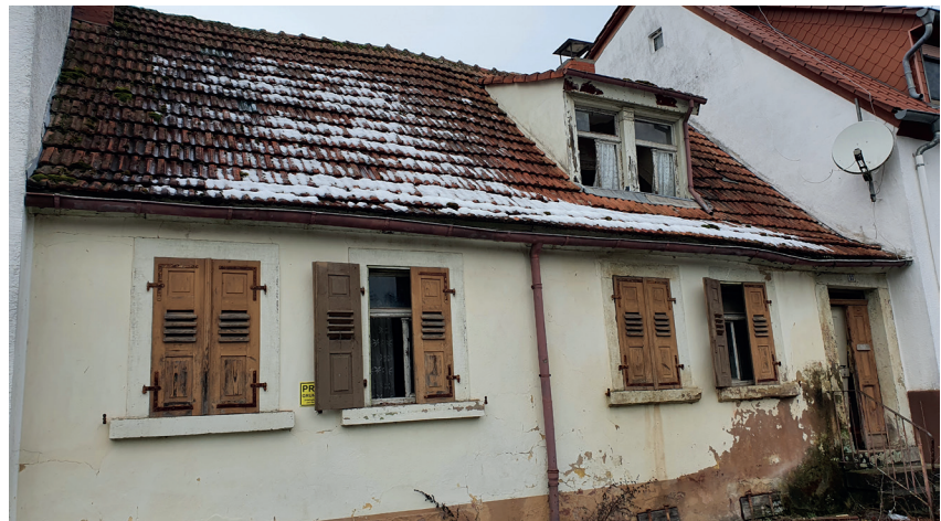
Leerstehendes Wohngebäude im Bereich „Kleine Gasse“
