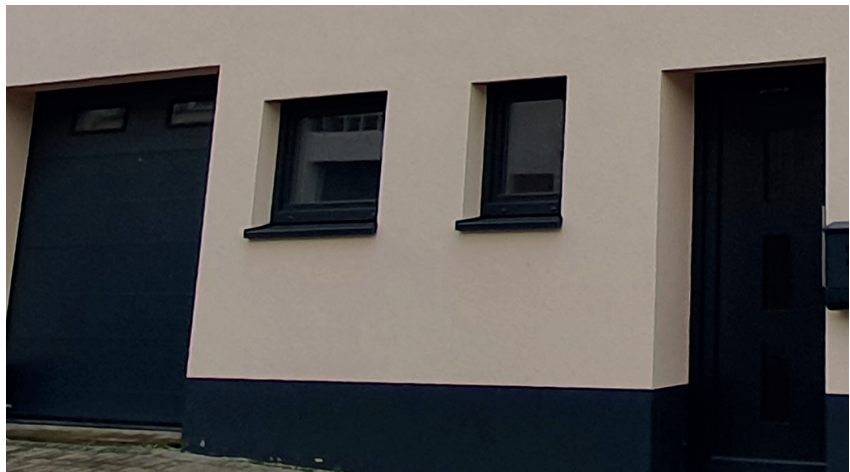
Modernisierungs- und Instandsetzungsbedürftiges Gebäude mit geringem Bedarf
