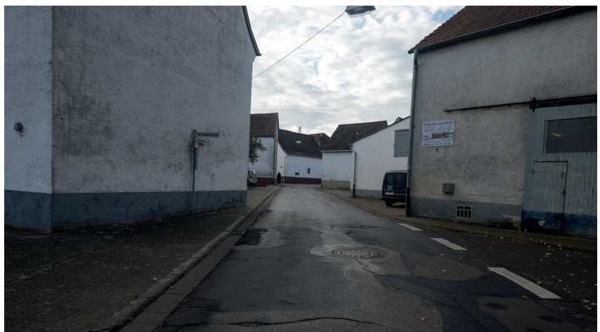
Funktionsmangel: nicht ortsbildgerechte Straßengestaltung
