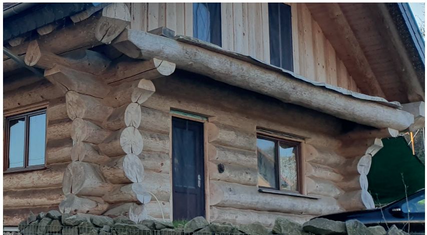
Beispiel für eine nicht ortsbildgerechete Bauart
