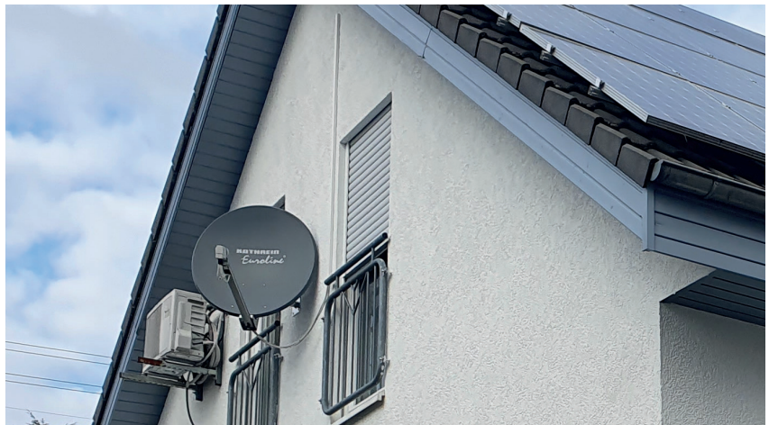
Modernisierungs- und instandsetzungsbedürftiges Gebäude mit geringem Bedarf
