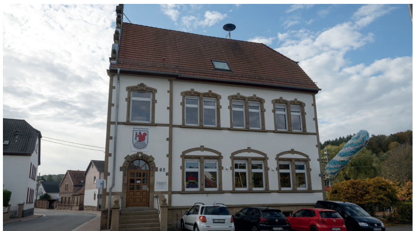
Denkmalgeschütztes Bürgerhaus, ca. 1900 erbaut (Hauptstr. 65), Hirschhorn
