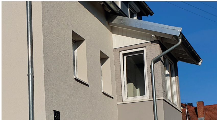
Modernisierungs- und Instandsetzungsbedürftiges Gebäude mit geringem Bedarf
