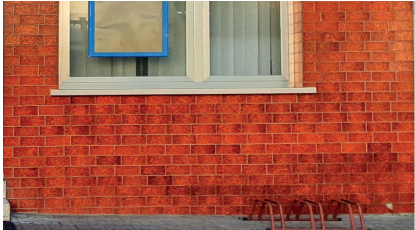
Ortsuntypische Materialität der Fassade
