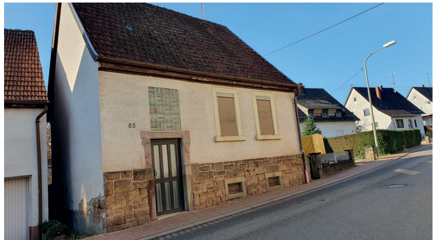
Leerstehendes Wohngebäude im Bereich der Hauptstraße
