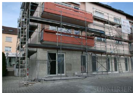
Foto 14: Umbau der ehemaligen Schlecker-Filiale in Ailingen zu Wohnungen
