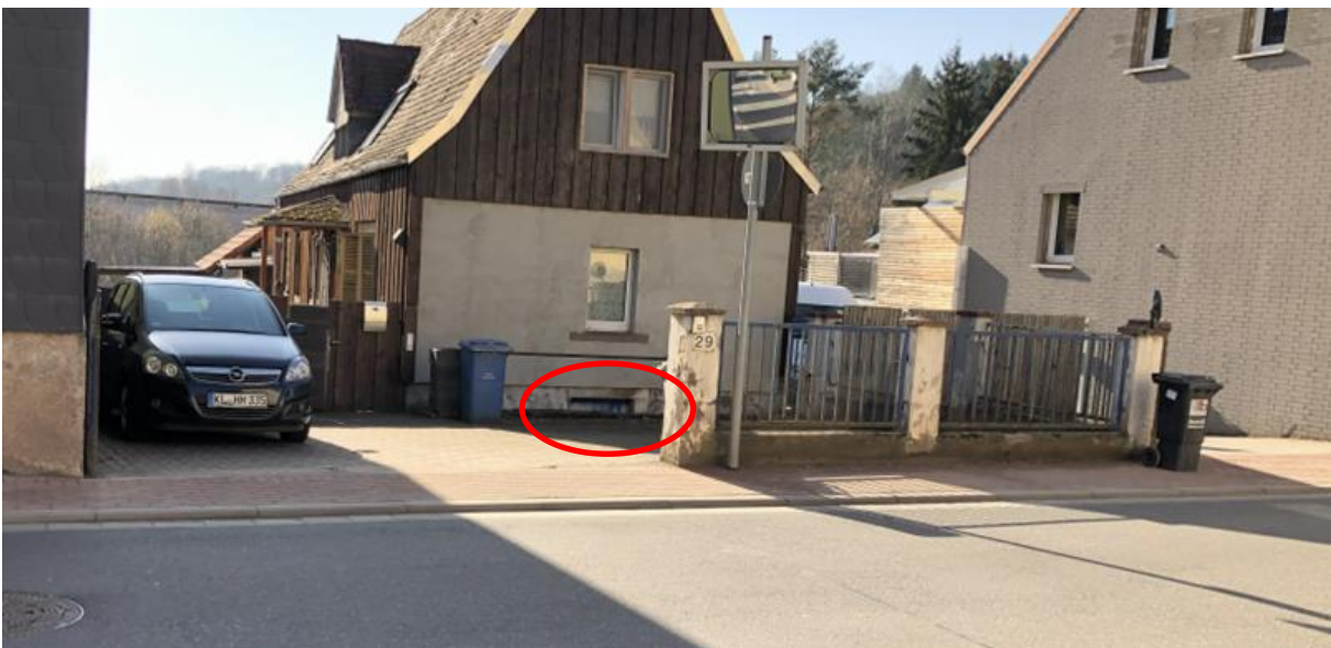
Abb. 119: Überflutungsgefährdete Bebauung an der Einmündung der Kettenbergstraße auf die B 270
