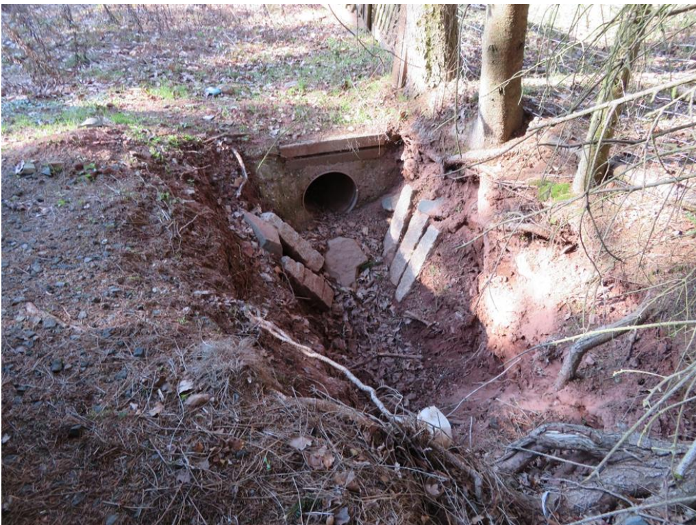
Abb. 74: Gewässerverrohrung im Bereich einer Grundstückszufahrt Am Köttenberg
