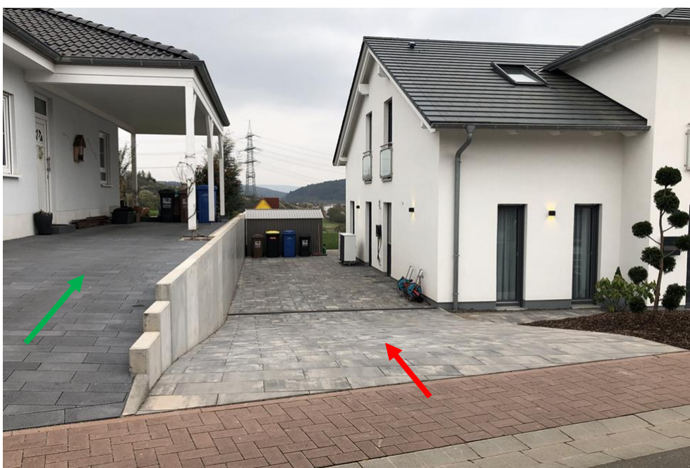
Abb. 19: Überflutungsfördernde (rot) und überflutungsresiliente Bauweise (grün)
