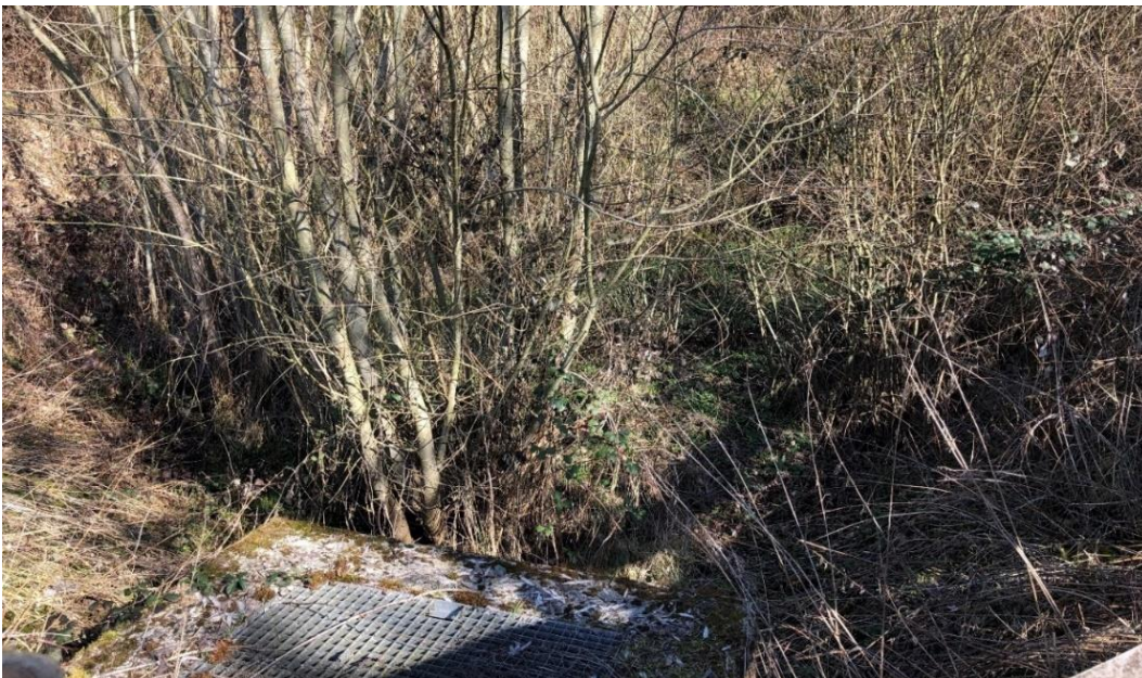
Abb. 88: Mönchbauwerk als Ablauf- und Überlaufbauwerk des Regenrückhaltebeckens
