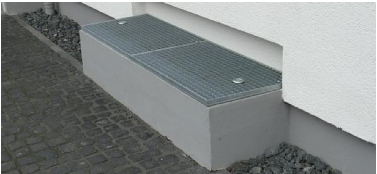
Abb. 21: Beispiel für die Sicherung eines niveaugleichen Lichtschachtes
