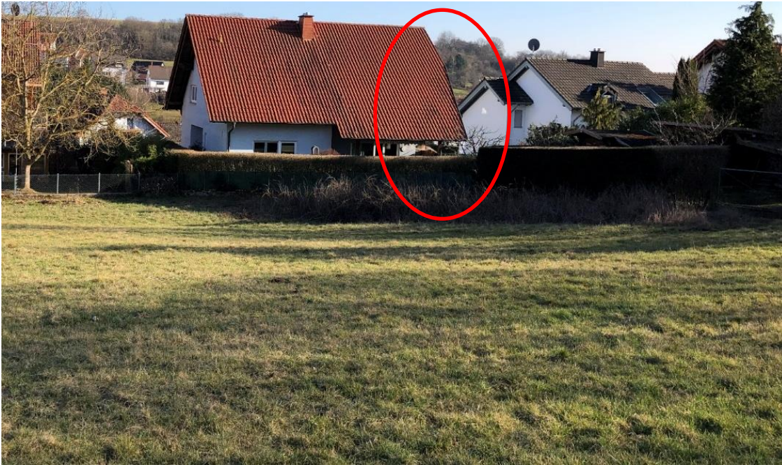
Abb. 101: Überflutungsgefährdete Wohnhäuser in der Flurstraße
