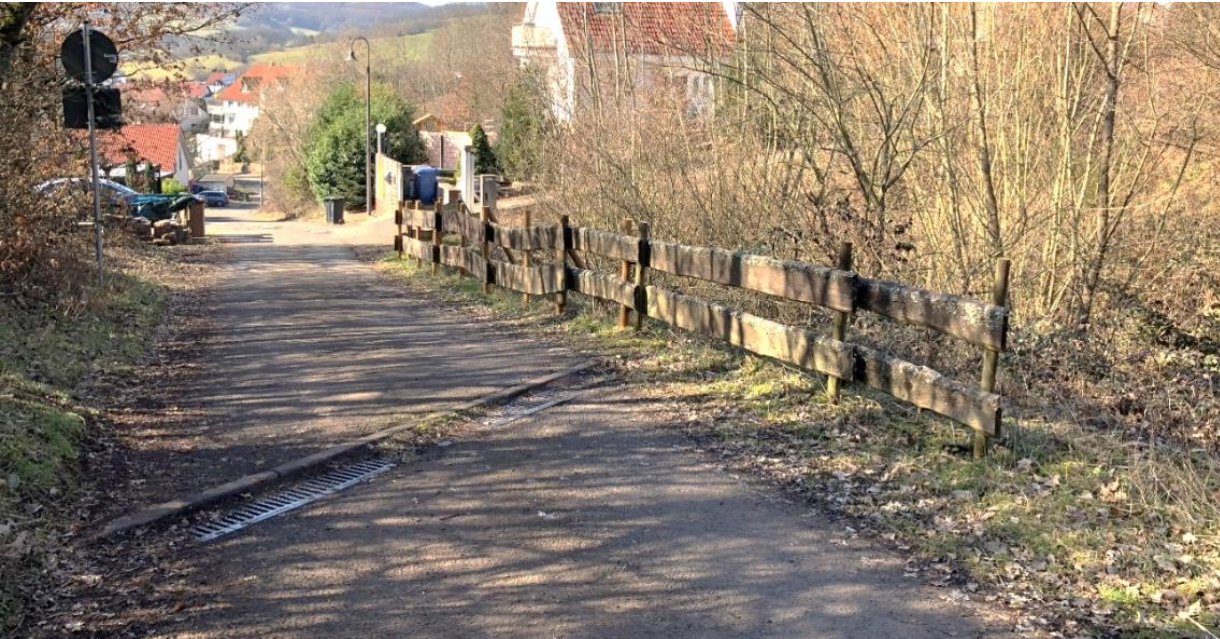
Abb. 89: Querrinne zum Regenrückhaltebecken in der Bergstraße am Ortsrand
