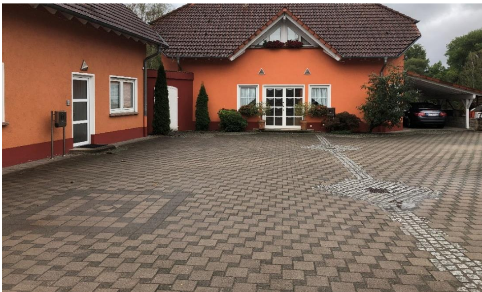
Abb. 18: Beispiel für Gebäude mit tiefliegenden Zugängen
