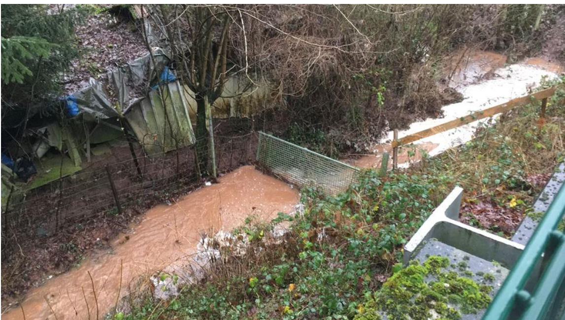
Abb. 76: Namenloses Gewässer in der Sonnenbergstraße mit Rechen bei Hochwasserabfluss 2016, Foto: Rudat
