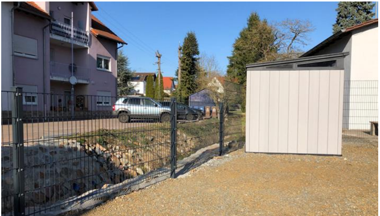
Abb. 62: Nebengebäude unmittelbar am überflutungsgefährdeten Bach (laut Bürgerversammlung Anfang 2021 erbaut)
