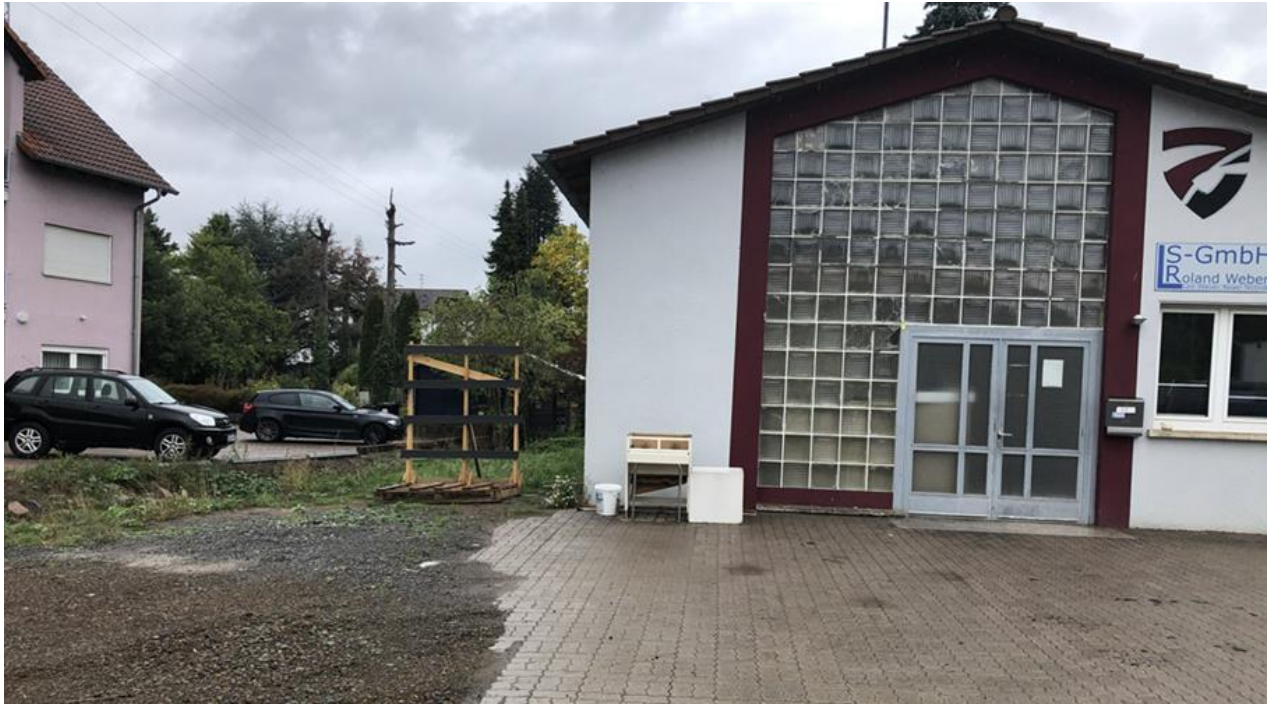
Abb. 61: Überflutungsgefährdeter Gewerbebetrieb am Wölbach
