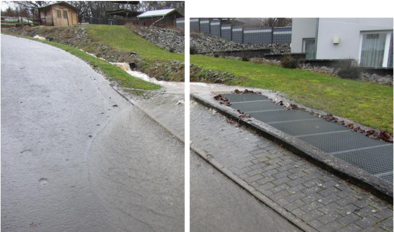
Abb. 115: Überlasteter Sandfang „Zum Kreimberg“ bei Starkregen 2016, Foto: NN über Ortsgemeinde
