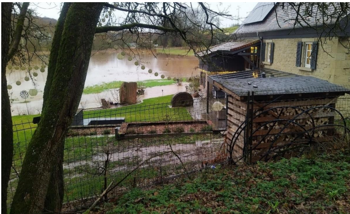
Abb. 35: Hochwasser der Mooslauter an der Hirschhorner Bordenmühle, 2021, Fotos: Fritz
