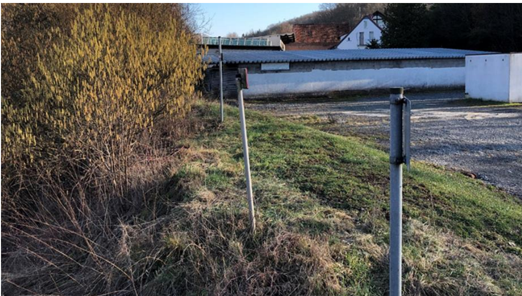
Abb. 30: Gebäude des Hirschhorner Hofes hinter Hochwasserschutzverwallung
