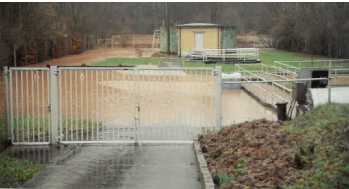
Abb. 46: Hochwasser der Lauter auf der ehemaligen Kläranlage (heute Pumpstation), 12/1993, Foto: Hässler-Kiefhaber
