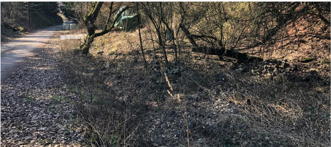
Abb. 70: Aufgefächerter Bachlauf mit deutlichen Erosionsschäden (Am Köttenberg)
