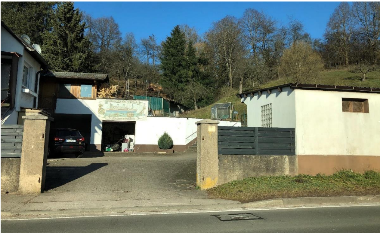
Abb. 118: Überflutungsgefährdete Bebauung und Nutzung am Ende eines Kerbtales
