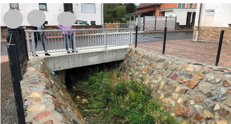
Abb. 60: Wölbach oberhalb der B 270 mit Brücke
