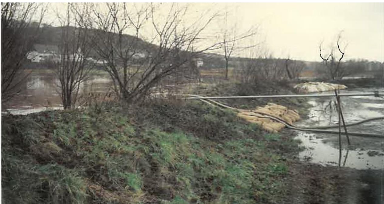
Abb. 28: Sicherungsmaßnahmen der Feuerwehr an der Hochwasserverwallung, 12/1993, Foto: Hässler-Kiefhaber
