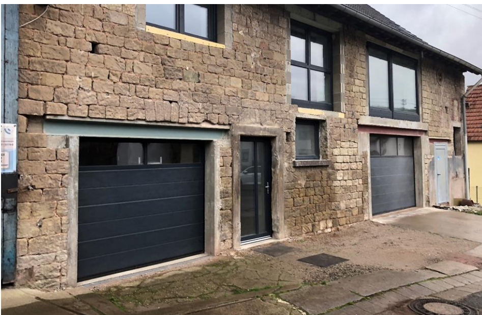
Abb. 94: Ausgebaute Scheune im Abflussweg
