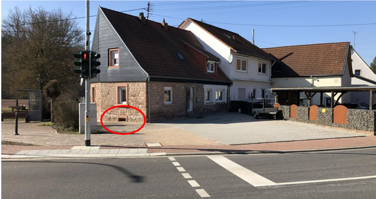
Abb. 122: Beispiel für potenziell überflutungsgefährdetes Gebäude an der Einmündung Bergstraße
