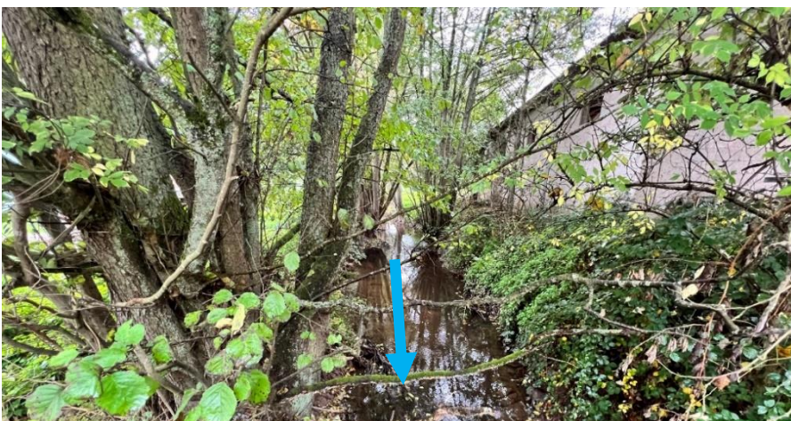
Abb. 37: Landwirtschaftliches Gebäude unmittelbar am Bach
