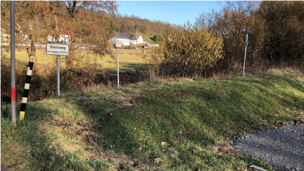
Abb. 29: Hochwasserschutzverwallung am Hirschhorner Hof, 2022
