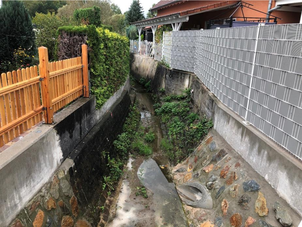
Abb. 63: Ausgebauter Wölbach unterhalb der B 270
