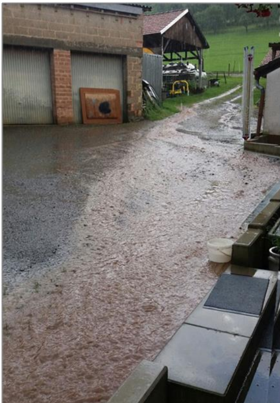
Abb. 96: Starkregenabfluss zur Bergstraße, Foto: Rudat Örtliches Hochwasser- und Starkregenvorsorgekonzept Hirschhorn
