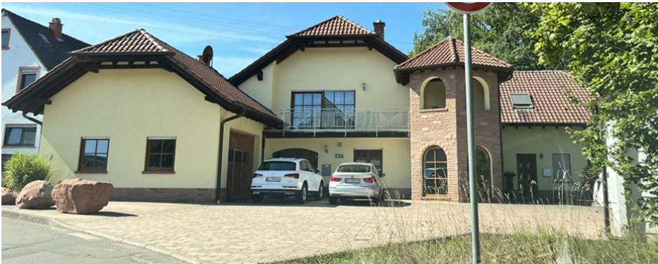
Abb. 99: Überflutungsgefährdete Nutzungen im Tal des Rudersbaches
