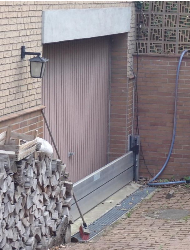
Abb. 21: Dammbalkenverschluss (links) und Schott (rechts)
