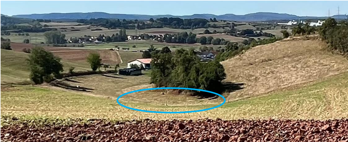
Abb. 66: Potenzieller Standort für einen Kleinrückhalt oder eine größere Rückhaltemaßnahme
