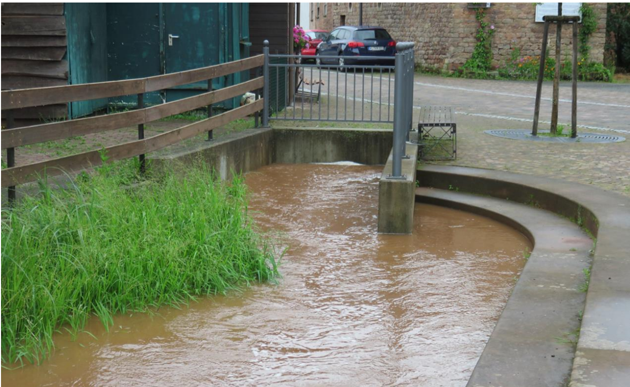
Abb. 92: Hochwasserabfluss im Becherbach in der Bachstraße am 25.06.2016, Foto: NN, Anlieger der Bachstraße
