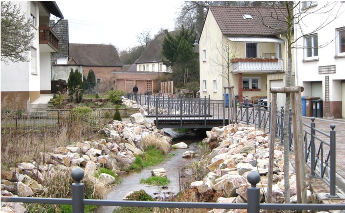
Abb. 94: Bach unmittelbar nach dem Ausbau 2013
