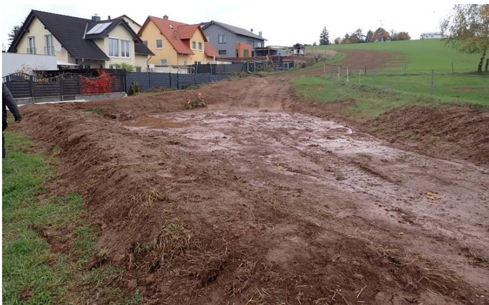
Abb. 69: Zulaufgraben und RRB unmittelbar nach der Nachprofilierung, 10/2020
