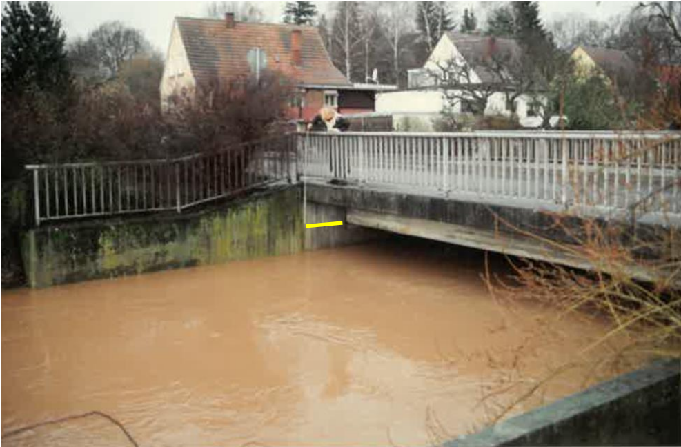
Abb. 22: Brücke Ziegelhütterstraße, Weihnachtshochwasser 1993, Foto: Hässler-Kiefhaber
