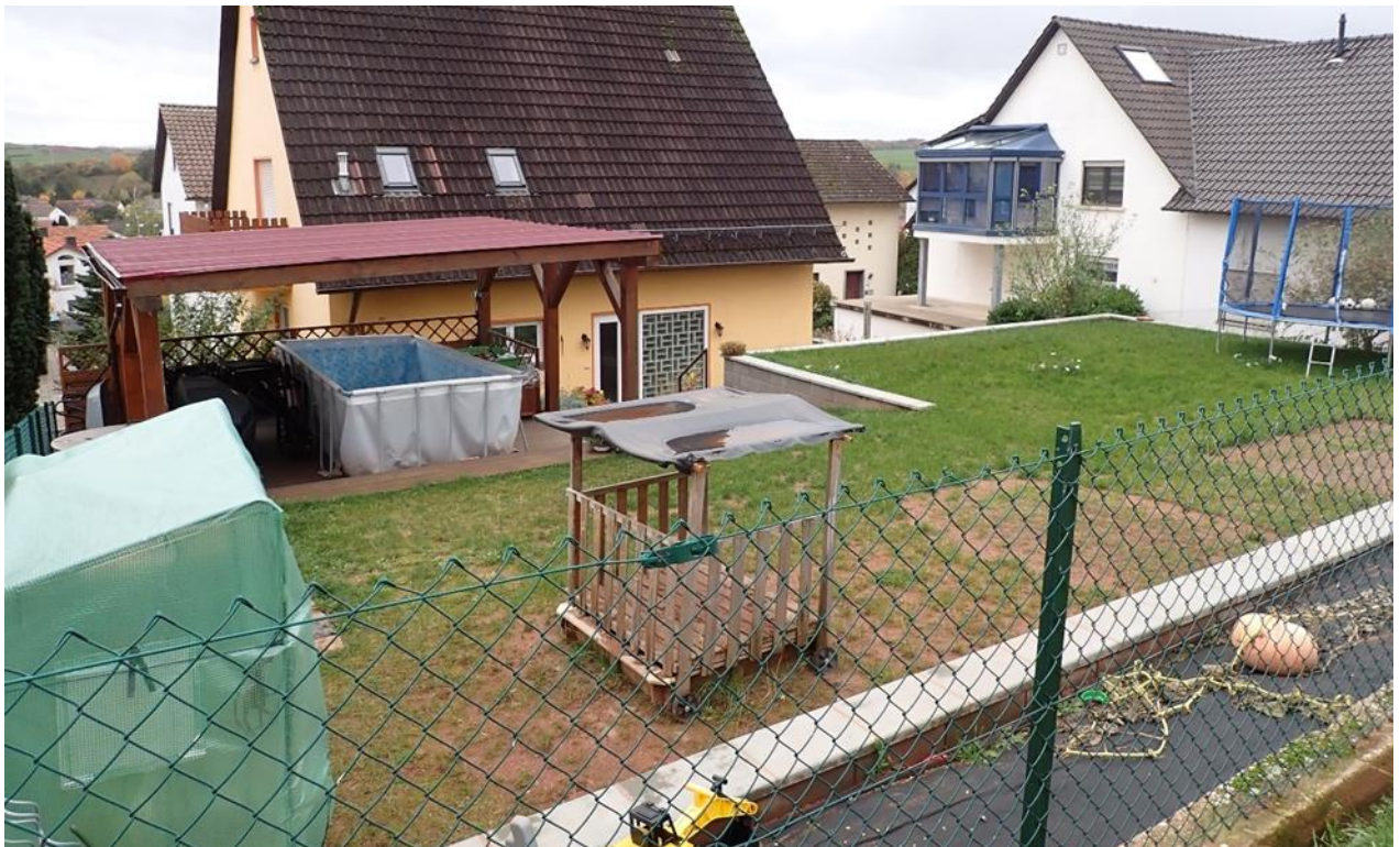
Abb. 74: Beispiele für überflutungsgefährdete Wohnhäuser in Hanglage
