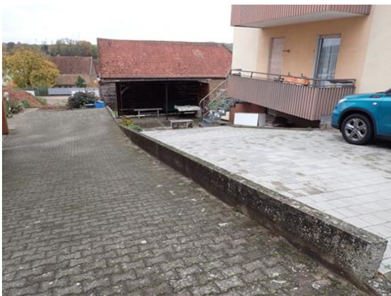
Abb. 77: Abschüssige Hofflächen zu unterhalb liegender Bebauung
