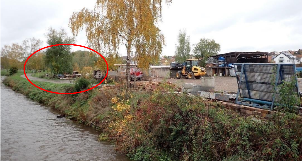
Abb. 38: Abtriebsgefährdetes Material im tiefliegenden Baustofflager im amtlichen ÜSG
