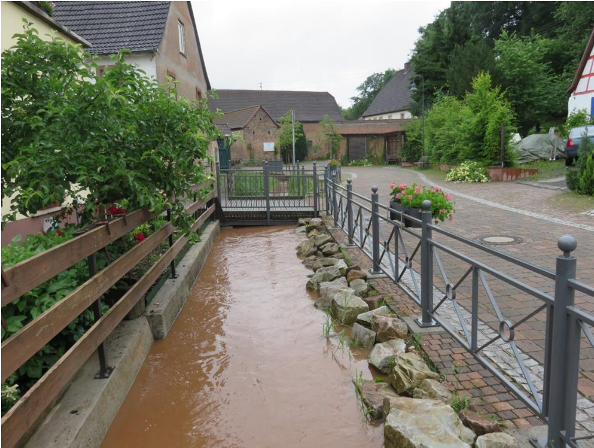
Abb. 93: Hochwasserabfluss im Becherbach in der Bachstraße am 25.06.2016, Foto: NN, Anlieger der Bachstraße
