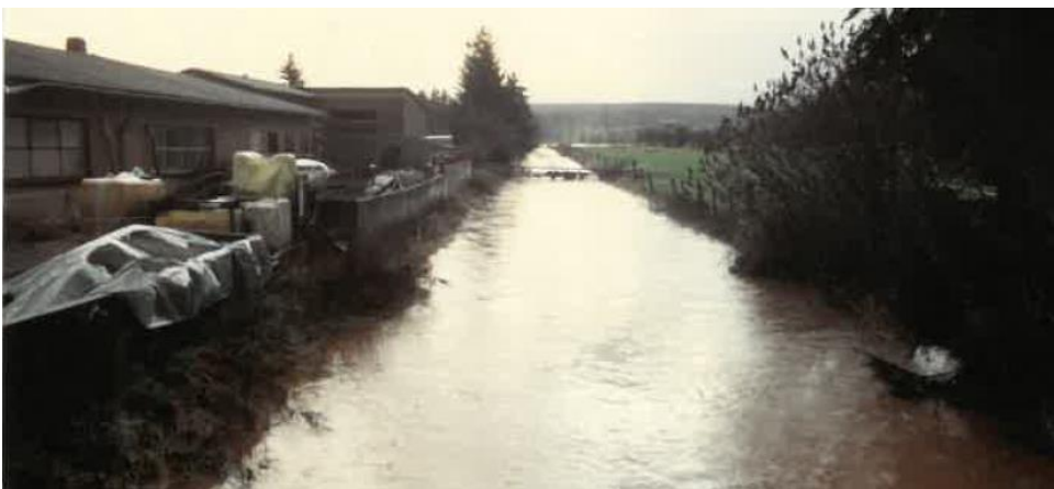
Abb. 24: Wasserstand bei abklingender Hochwasserwelle 1993 oberhalb der Brücke Ziegelhütterstraße, Foto: Hässler-Kiefhaber
