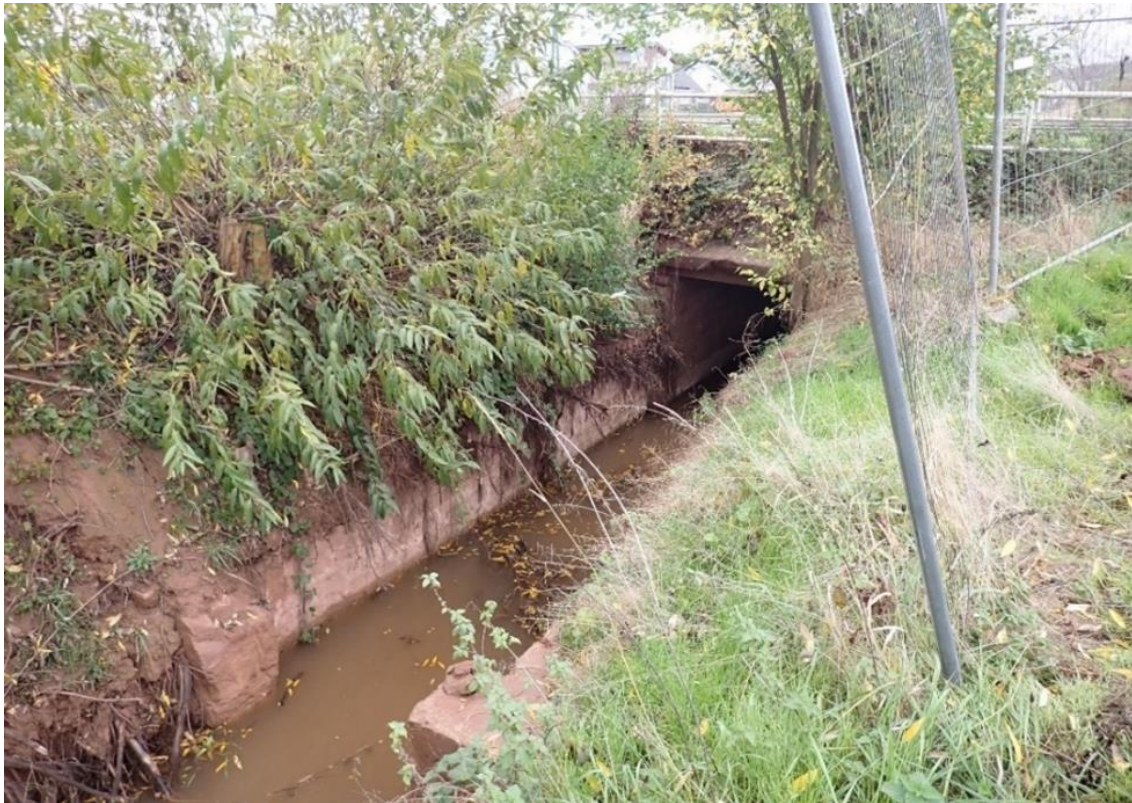
Abb. 56: Bahndurchlass und Graben „Große Gräben“
