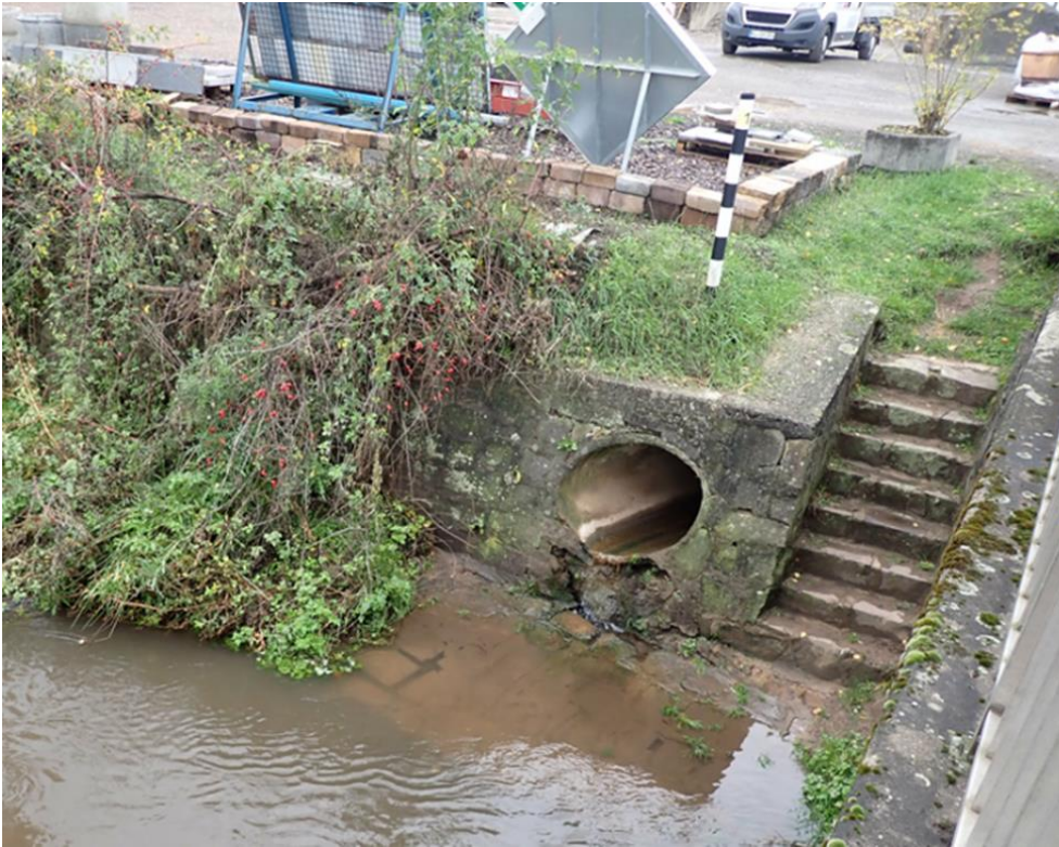
Abb. 32: Einleitstelle der Regenwasserkanalisation in die Lauter unterhalb der Brücke
