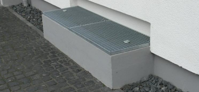
Abb. 19: Beispiel für die Sicherung eines niveaugleichen Lichtschachtes
