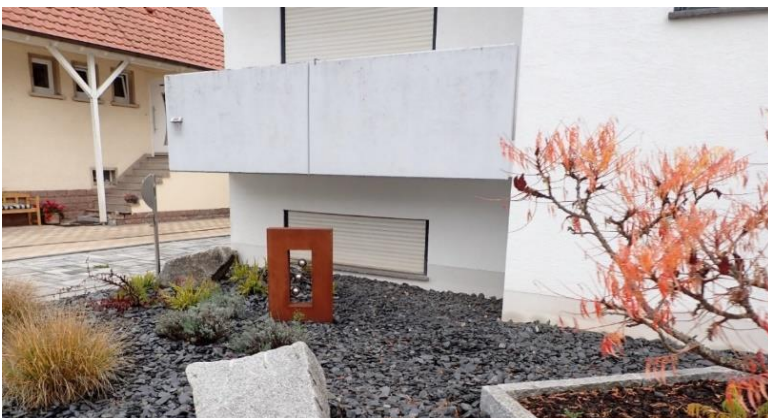
Abb. 18: Beispiele für überflutungsgefährdete Gebäude durch unangepasste Bauweise
