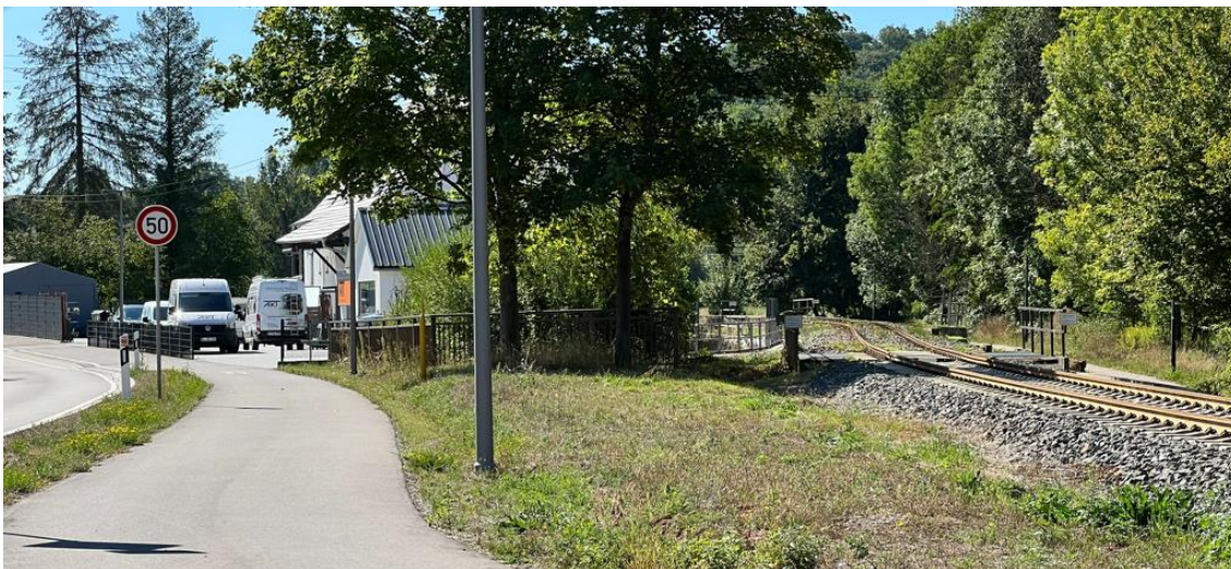
Abb. 48: Potenziell überflutungsgefährdeter Gewerbebetrieb
