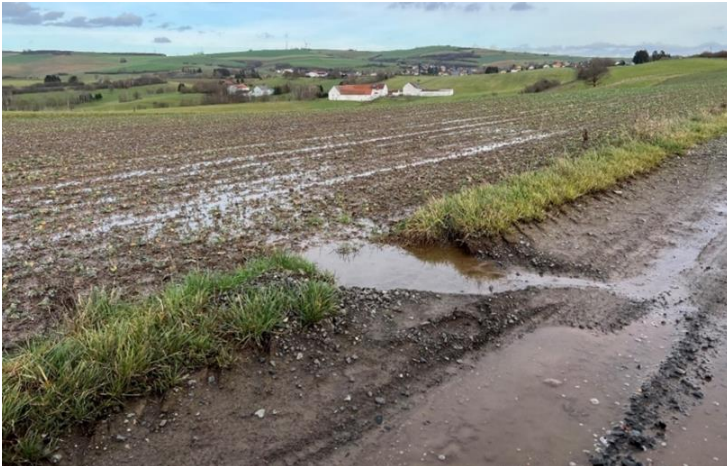
Abb. 13: Beispiel für Querentwässerung eines Wirtschaftsweges in die Ackerfläche
