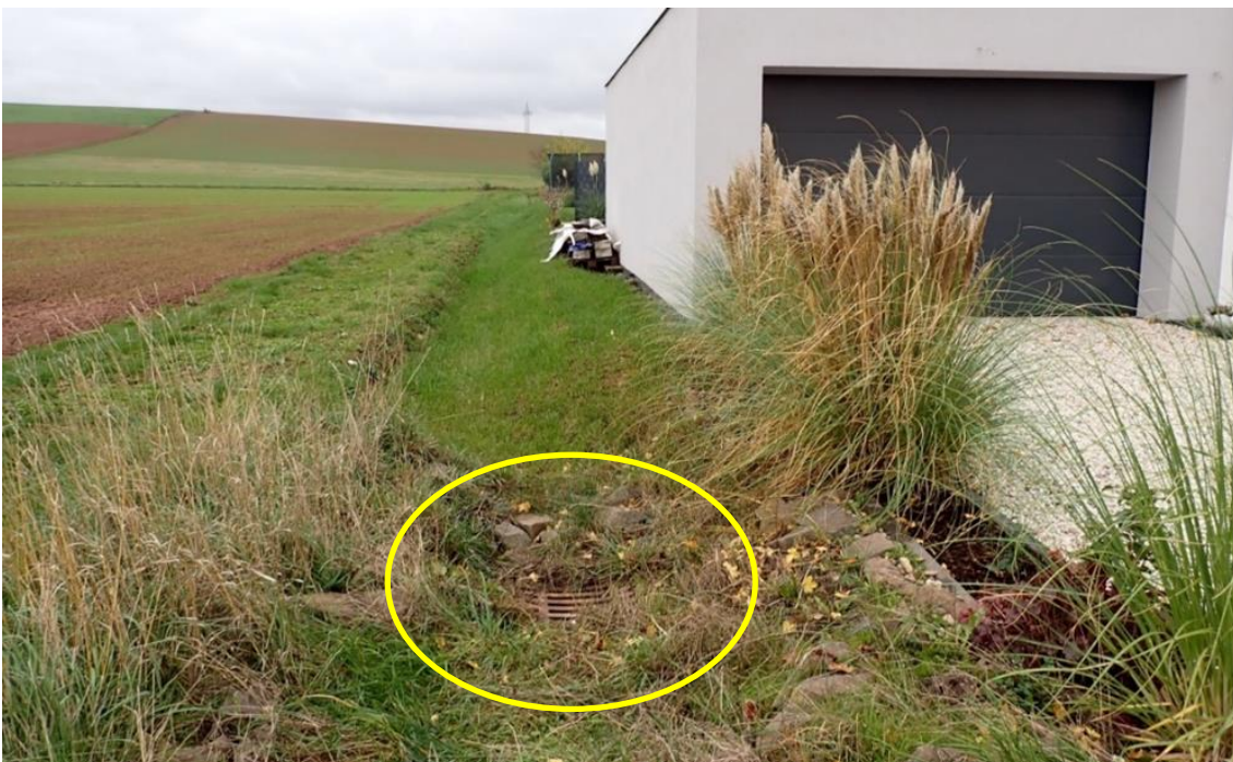
Abb. 59: Verwallung und Abfangegraben entlang der Randbebauung des Baugebietes „Hartwiesen“
