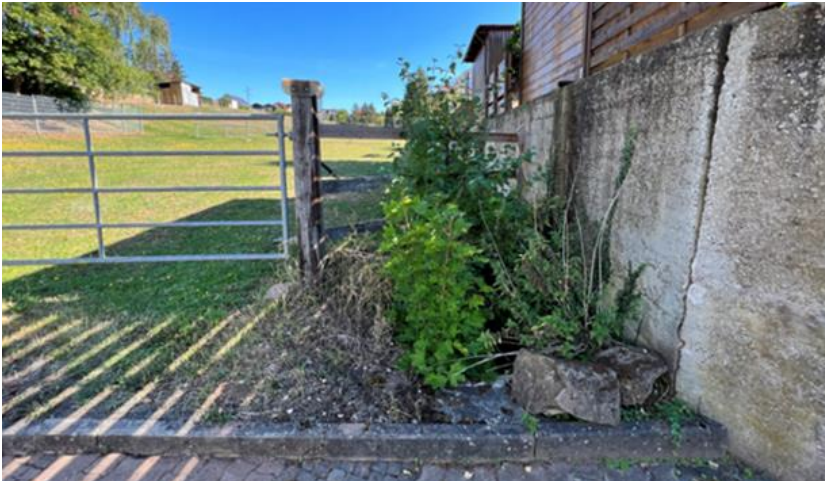
Abb. 83: Beginn der Verrohrung am Weg Hartmannsgraben
