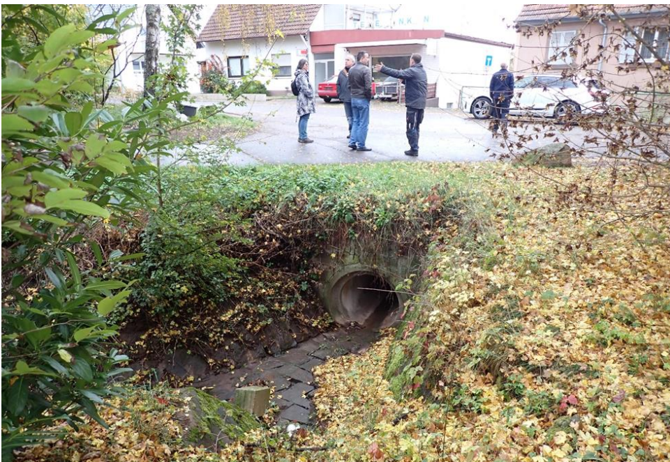
Abb. 102: Beginn der Rudersbachverrohrung zur Lauter
