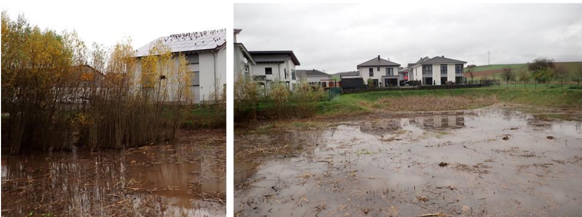
Abb. 55: Zentrales Rückhalte- und Versickerungsbecken als wasserwirtschaftliche Ausgleichsmaßnahme
